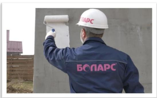
При использовании декоративных штукатурок на силиконовой основе «Mineral-S» следует применять грунт «Sil-primer», грунт «Sil-primer color» или «Sil-Primer quartz», белый или заколерованный пигментными пастами в цвет наносимого декоративного покрытия.
