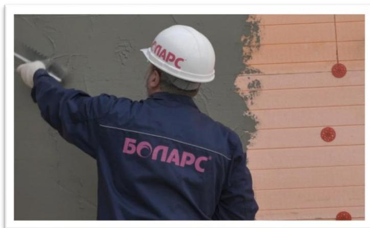
Далее излишки раствора снимают зубчатой стороной гладилки, при этом гладилку надо держать под углом 60°. Клей наносится снизу вверх. Использование зубчатой гладилки позволяет контролировать толщину нанесения клея и расход растворной смеси! При создании «антивандального» армирующего слоя в нижней части здания (на высоте до 2,5 м) используется специальная панцирная стеклосетка, обладающая более высокими физико-техническими характеристиками, или фасадная стеклосетка, уложенная в два слоя.
